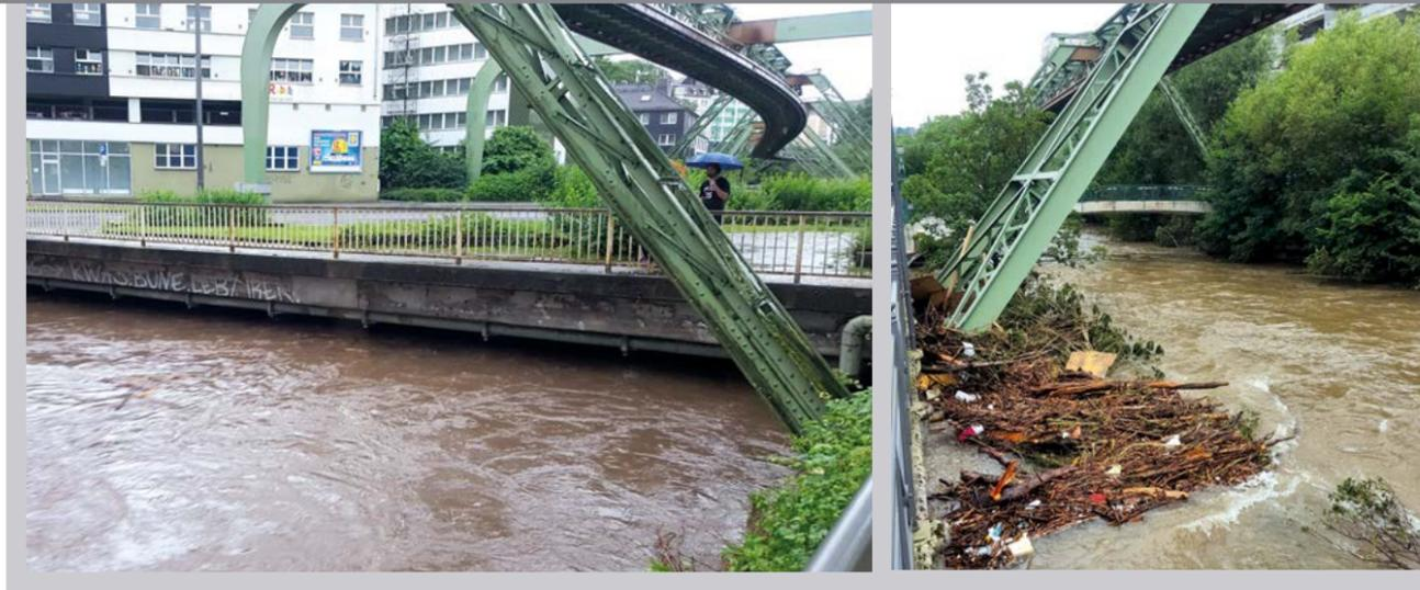
Abb. 7: Ein zu geringes Freibord an Brücken stellt im Zusammenhang mit Treibgut die häufigste Ursache für Überflutungen an kleineren Flüssen wie der Wupper dar. (Sturzfluten: Maßnahmen an der hydraulischen Infrastruktur)
