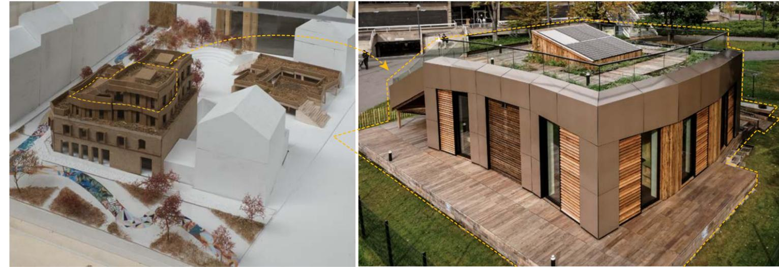
Abb. 4: Idee für das Café ADA aus Eindhoven: Das Wettbewerbs-Team setzt bei der Fassadengestaltung auf Holzelemente und in die Fassade integrierte Photovoltaik. ©VIRTUe / SDE 21/22
