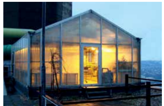
Abb. 1: Gewächshaus auf dem Gebäude G, Campus Griffenberg.
