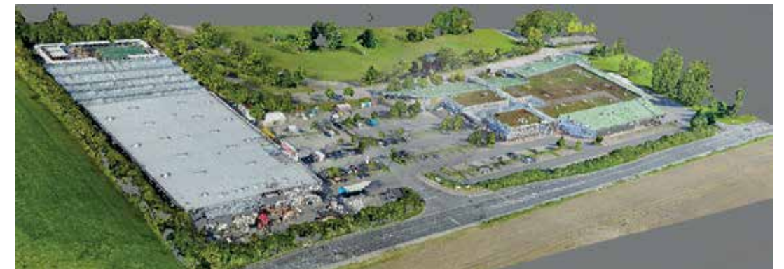
Abb. 4: Einsatz von Drohnen zur Generierung von Umgebungsmodellen mittels Photogrammetrie.
