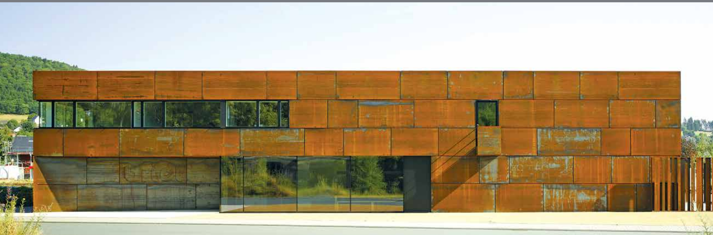
Abb. 1: m.schneider a.hillebrandt architektur: Metallwerkstück Briel – Fassade zu 100 Prozent wertsteigernd zu recyceln.
