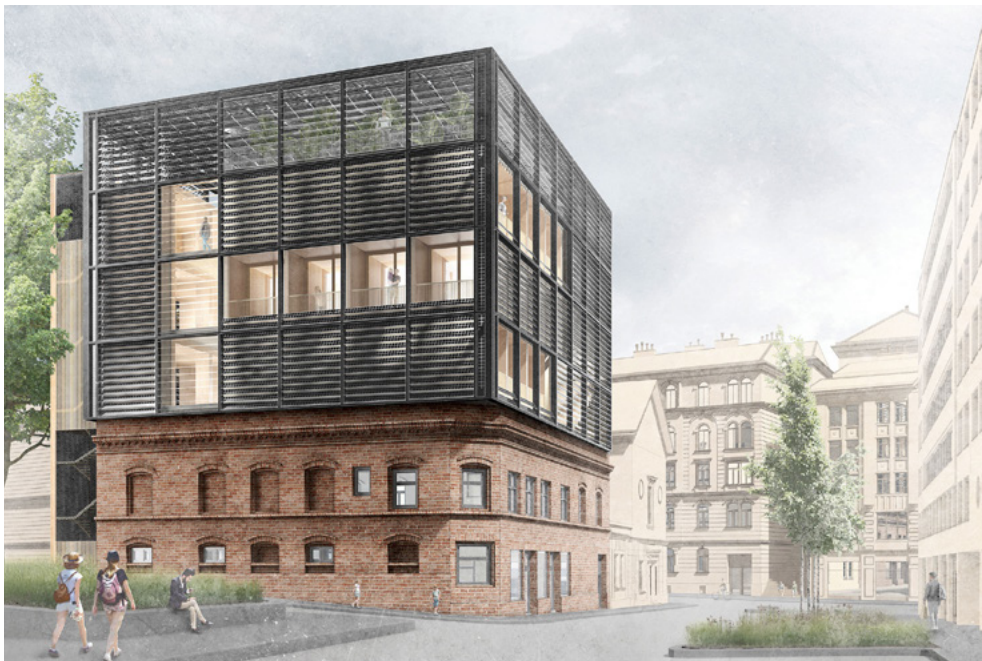
Café ADA Duesseldorf: Vollholz-Module, Klimahülle und Dachterrasse – die Aufstockungsidee des Teams der Hochschule Düsseldorf für das Café ADA. © MIMO / SDE 21-22
