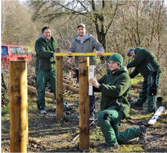
Tom Schürhoff (2.v.l.) vom Technischen Gebäudemanagement der Bergischen Universität und Mitarbeiter des Wuppertaler Gartenbauunternehmens Mechler legen eine Benjeshecke neben Gebäude W an der Gaußstraße an. Foto Gertrud Lohaus
