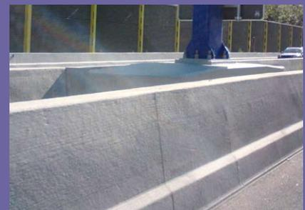
Abb. 1: Betonschutzwand mit Step-Profil.
