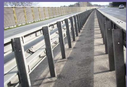
Abb. 2: Zweifache 'Super rail' Stahl Schutzplanke.
